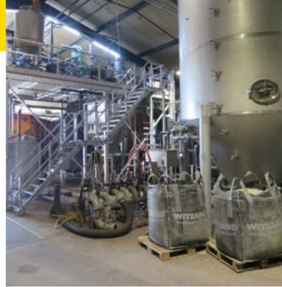
Foto links van de Groene Mineralen Centrale bij Groot Zevert Vergisting te Beltrum (Achterhoek) en rechts van de grootschalige installatie om fosfaat terug te winnen.
